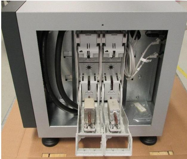
Abbildung 4-13 Batteriespeichersystem, Seitenansicht, Leistungstrenner gezogen
